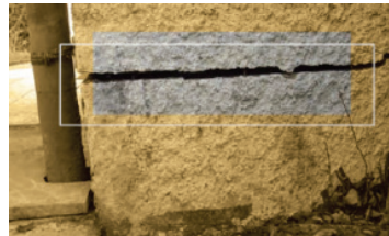
Fissuration sur le bâti dû à un retrait-gonflement des argiles
