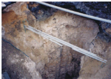
Phénomène de dissolution du suite à une rupture de canalisation
