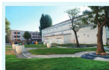
ÉLÉMENTAIRE CLAUDE-BERNARD Réalisation de la première tranche d'une cour de récréation végétalisée et inclusive.
