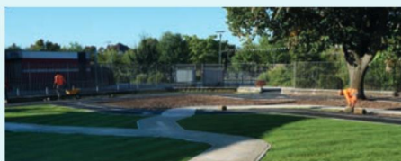
ÉLÉMENTAIRE LAMARTINE Réalisation de la première tranche d'une cour de récréation végétalisée et inclusive, création d'une salle de classe dans les locaux du centre de loisirs, réfection des grilles, étanchéification du toit, retrait des estrades dans les classes.
