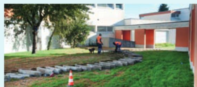
GROUPE SCOLAIRE MARIE-CURIE Réalisation de la première tranche d'une cour de récréation végétalisée et inclusive, changement de l'intégralité du mobilier, remise en peinture des classes, pose de nouveaux portails.
