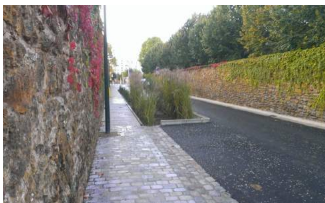
Espace végétalisé décaissé alimenté par l'eau pluviale via des caniveaux à ciel ouvert, Asnières - ATM
