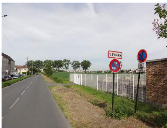
La cuve de Sevrans vue depuis le chemin du Marais du Souci - ATM
