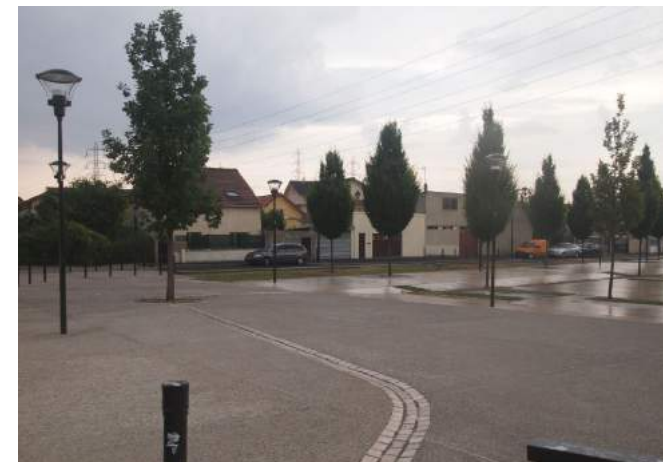
Caniveau alimentant une fosse d'arbre décaissée - Parvis du collège Lucie-Aubrac à Villetaneuse
