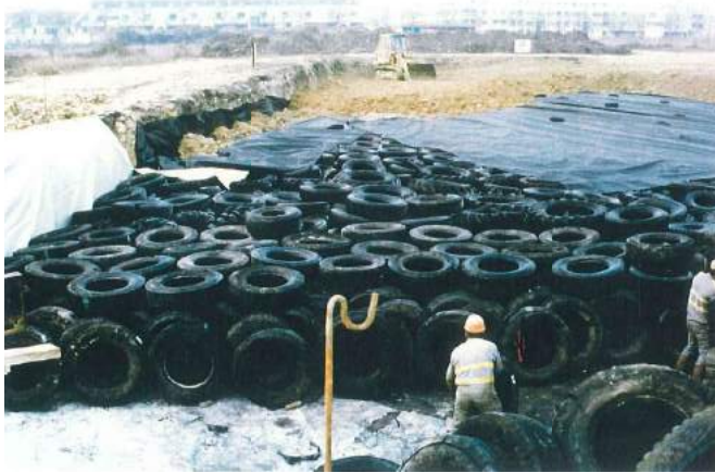
Réalisation du bassin pneu (pose des pneus) - DEA93
