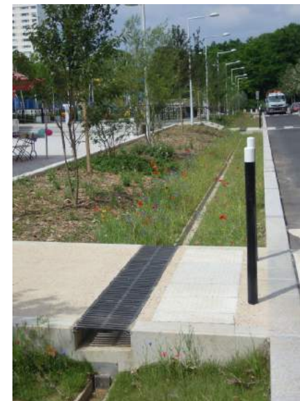
Noue intégrée au paysage urbain avec bief piéton, 4000 Nord
