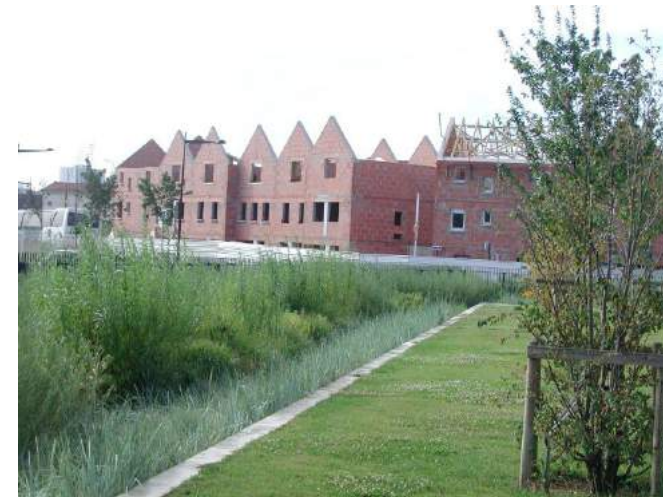
Une noue très végétalisée, qui permet notamment de «cacher» la clôture - ZAC Marcoux, Aubervilliers
