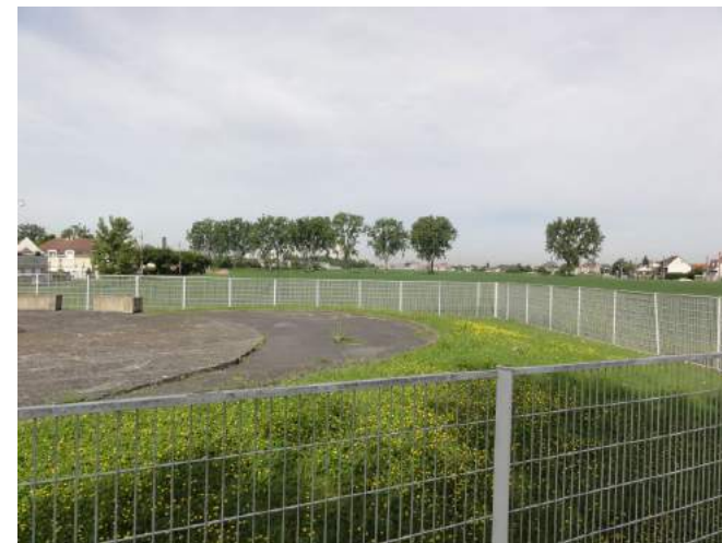
La cuve de Sevrans vue depuis la rue du Souci - ATM
