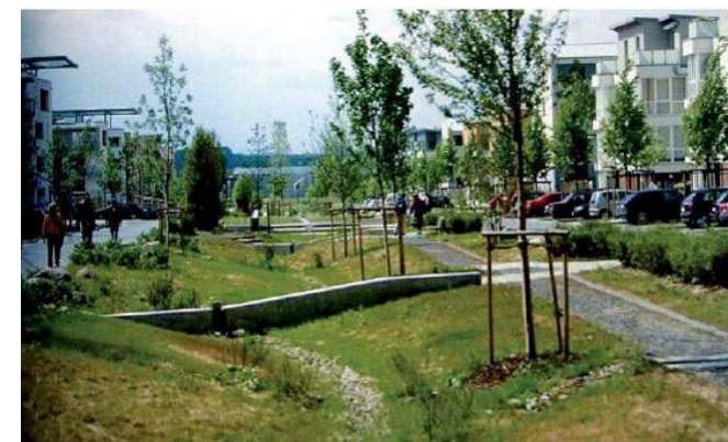
Noue en bordure de cheminement piéton
