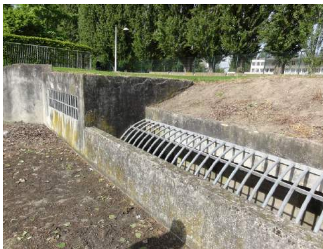
Ouvrage de surverse du bassin B2 vers la Morée EP - ATM
