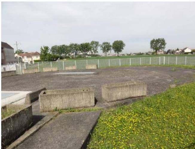
La cuve de Sevrans vue depuis la rue du Souci - ATM
