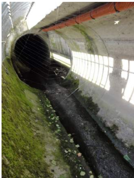
La Morée EP (Ø1600) au droit de l'ouvrage de surverse du bassin B2 du bassin de la Mare aux Poutres - ATM
