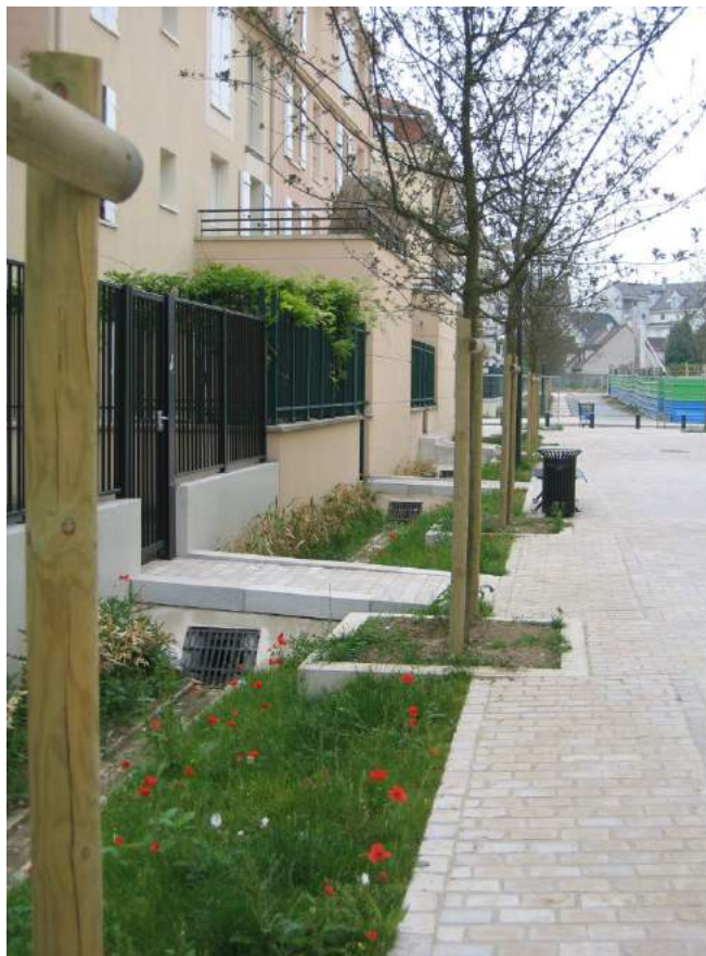
Noue en bordure de mail piéton, ZAC du Clos Saint Vincent, Noisy le Grand
