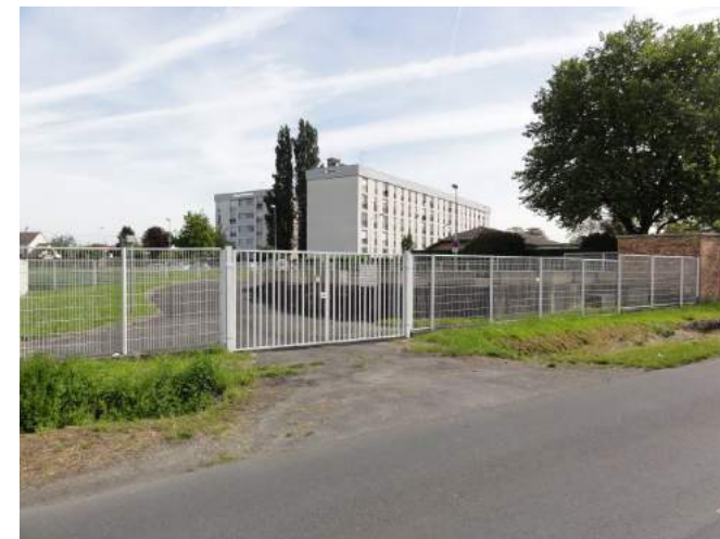
La cuve de Sevrans vue depuis le chemin du Marais du Souci - ATM
