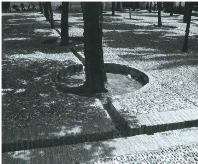
Caniveaux à ciel ouvert alimentant en eau les fosses d'arbres, Cordoue
