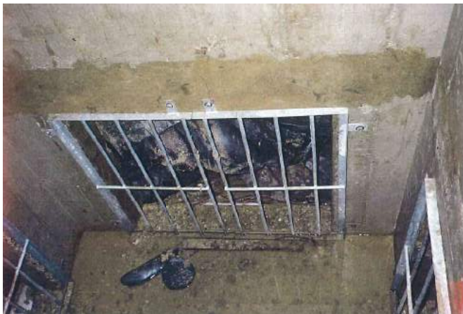
Ouvrage de diffusion - DEA93
