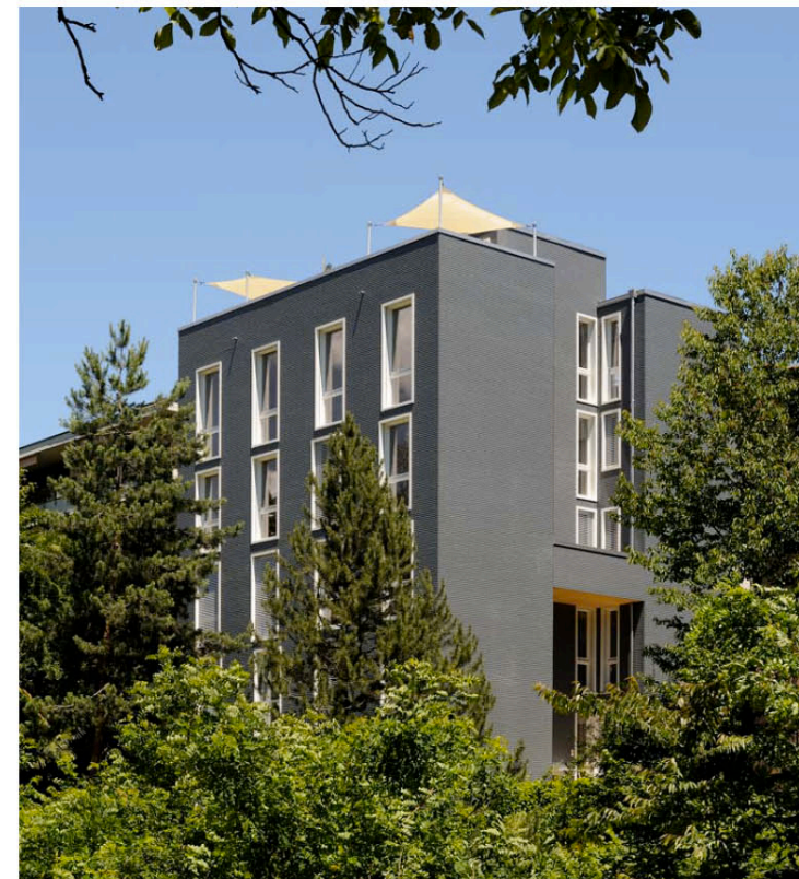
Construire autrement Construction en Bois (Italie)
